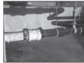
地下ピット内
