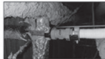
銅管から架橋ポリエチレン管で修繕完了
