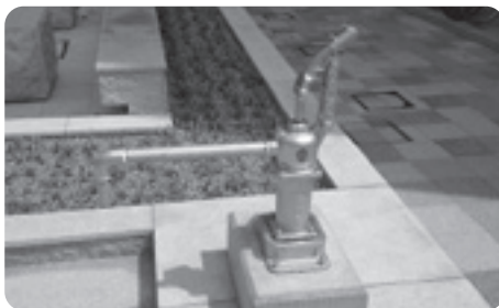
※写真は吐出し管を延長してあります。 ※通行時の安全確保のためハンドルを外しています。
