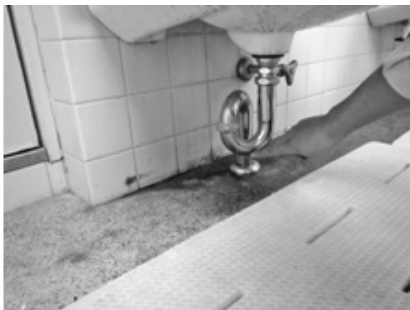
第 13 回市営保育所水廻り点検 (周山保育所) トイレ 手洗器排水漏水
