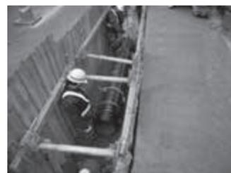
また、漏水を防止するとともに、市民の皆様により安全・安心で良質な水道水を供給するために道路部分に残存する鉛製給水管の取替えを年間 12,600 件実施し、平成 29 年度末までに道路部分の鉛製給水管の解消を図ります。
