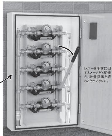
レバーを手前に倒すとメータが45°傾き、計量指示を読むことができます。
